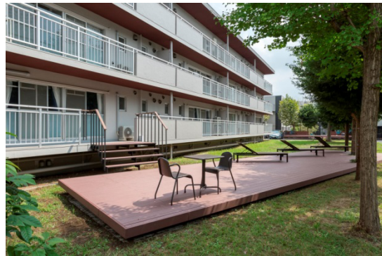
シェアラウンジの前に設置したウッドデッキスペース
