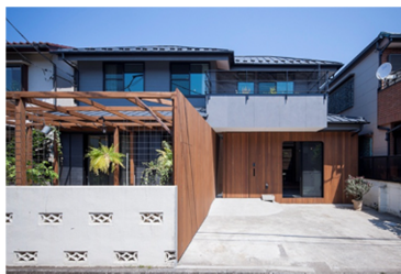
戸建てリノベーション
