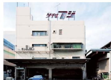
建物外観(再生前)
